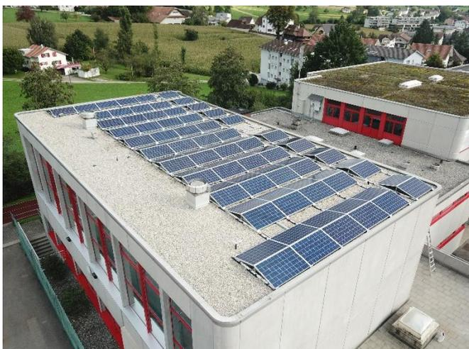
Die Module dieser Anlage wurden Ost-West ausgerichtet, damit möglichst viel produzierte Energie direkt für den Eigenverbrauch der Schule bereitgestellt werden kann.
